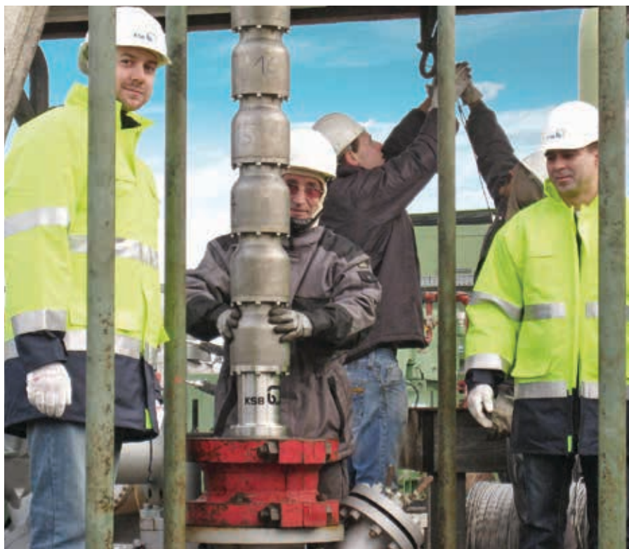
Монтаж на месте эксплуатации оборудования
